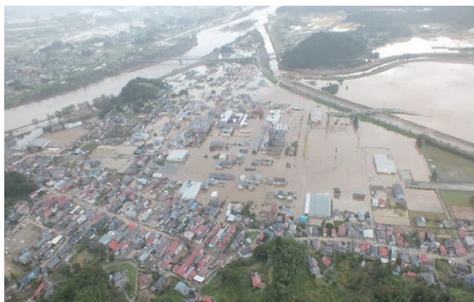
「令和元年東日本台風」による浸水被害 宮城県丸森町(山形県消防防災航空隊提供)
